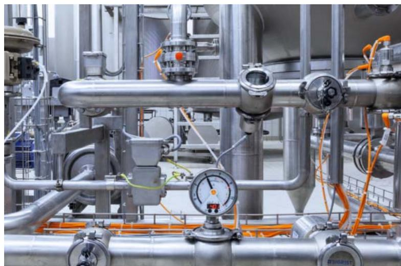
*2-in-1: Das vollelektronische Kontaktmanometer PG vereint Drucksensor und Manometeranzeige in einem Gerät.*
