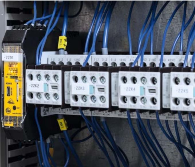
ifm bietet verschiedene Module für den Schaltschrank, die Feldmontage oder als Platinenlösung an. Erhältlich sind diese mit unterschiedlichen Konfigurationen an digitalen Ein- / Ausgängen, analogen Ein- / Ausgängen oder speziellen Anschlüssen, etwa für Pt-100-Tempersensoren.
