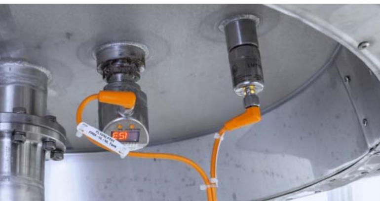
Typische Tanküberwachung: Grenzstandsensor LMT und hydrostatisch messender Drucksensor PI im Tankboden.
