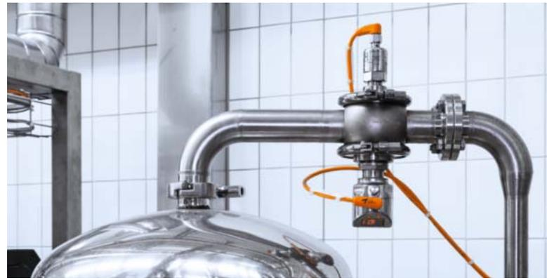
*Perfekter Pumpenschutz: Der Grenzstandsensorm LMT (oben)
