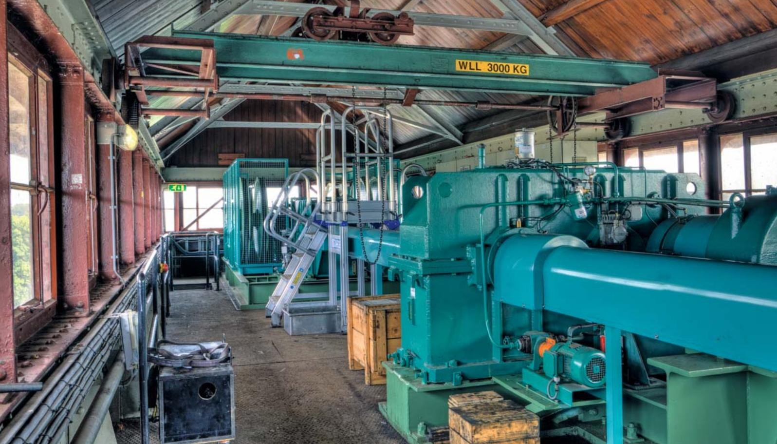
*Der Antriebsstrang zum Heben und Senken der schweren Schleusentore. Die Zustände von Motoren, Wellen und Getrieben werden permanent mittels Schwingungsdiagnose überwacht.*
