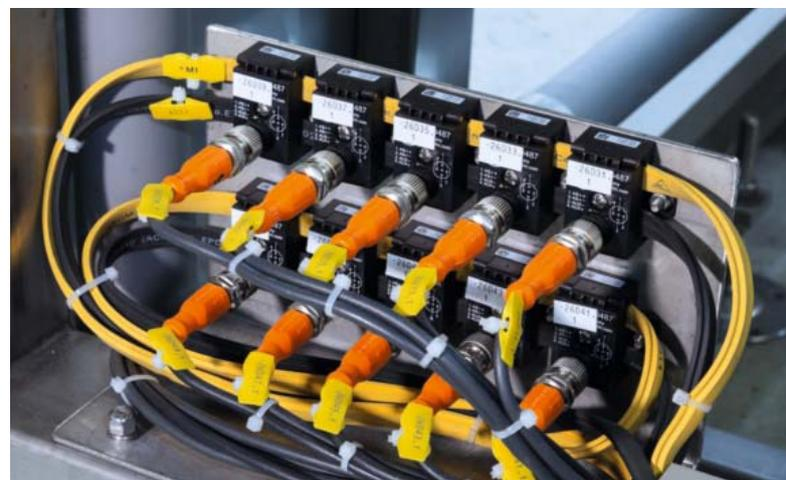
Passive Flachkabelabgriffe zum Anschluss intelligenter AS-i Sensoren / Aktuatoren an das gelbe Flachkabel.
